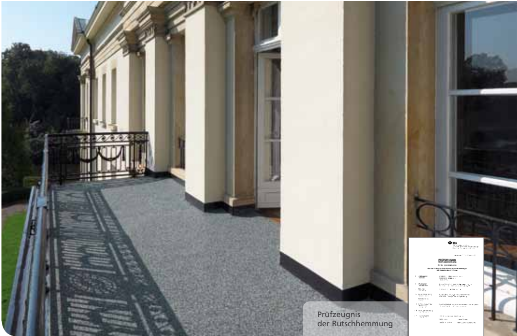
Sanierung einer Terrasse mit COETRANS® DS in dem Farbton: Grün
