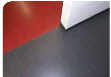
Übergang Aufenthaltsraum - Lagerhalle beschichtet mit COEPLAN FC in verschiedenen Farbtönen
