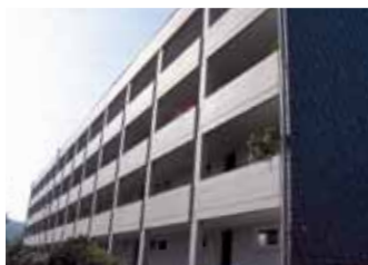
Laubengänge einer Wohneinheit in Frankfurt
