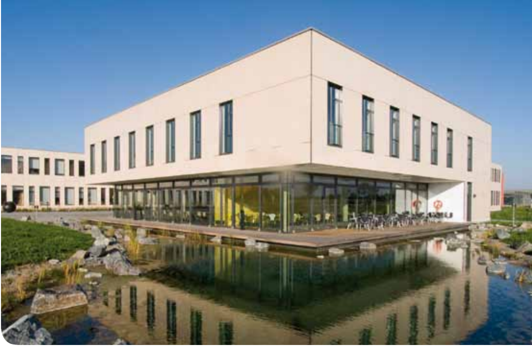
Sanierung der Aussenfassade der Bundesanstalt für Züchtungsforschung in Quedlinburg mit COELAN® Holzbeschichtung
