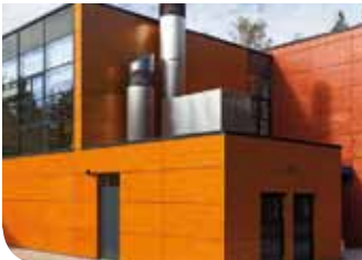
Welpenhaus in Nürnberg, Rückansicht
