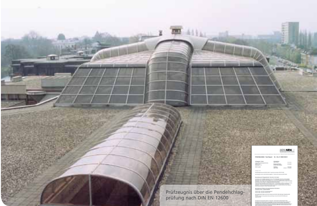
Sanierung eines Glasdaches der Universität in Leiden mit COETRANS® – Transparent
