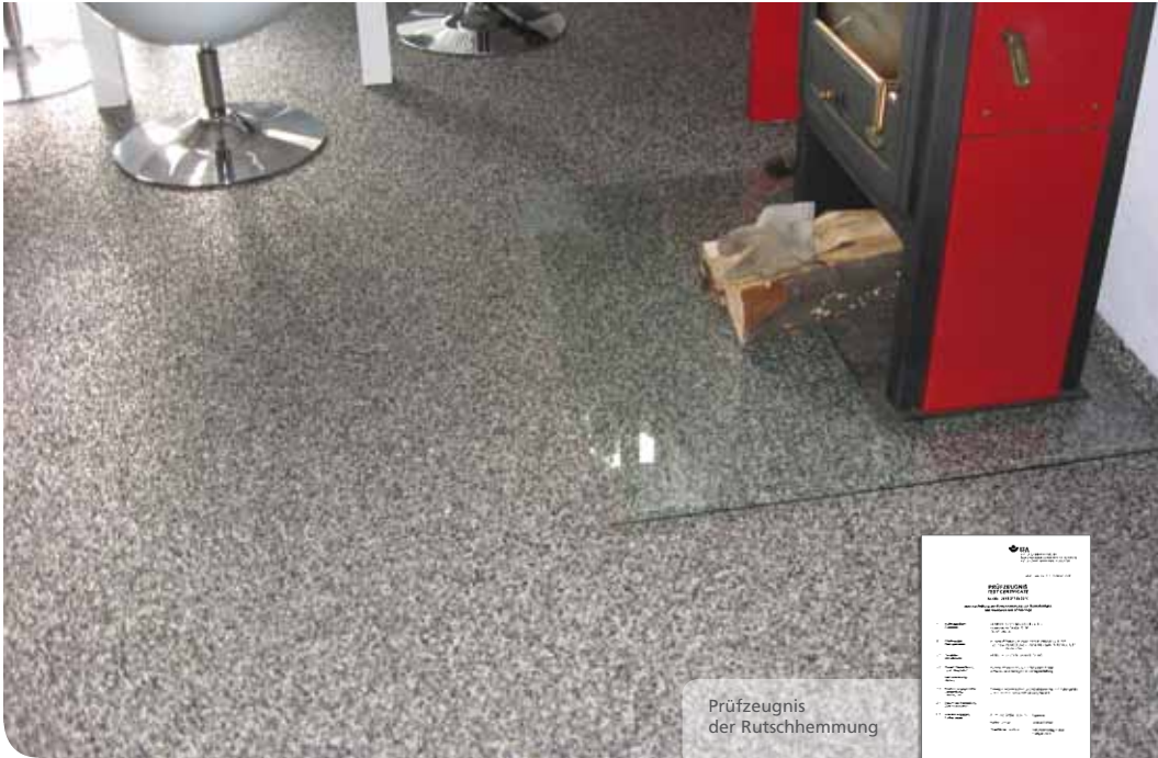
Sanierung der Bodenbeschichtung mit COEPLAN DS - Natursteinen
