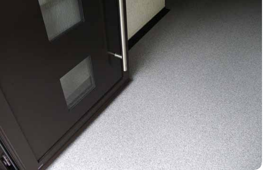
Sanierung der Bodenbeschichtung mit COEPLAN CQ
